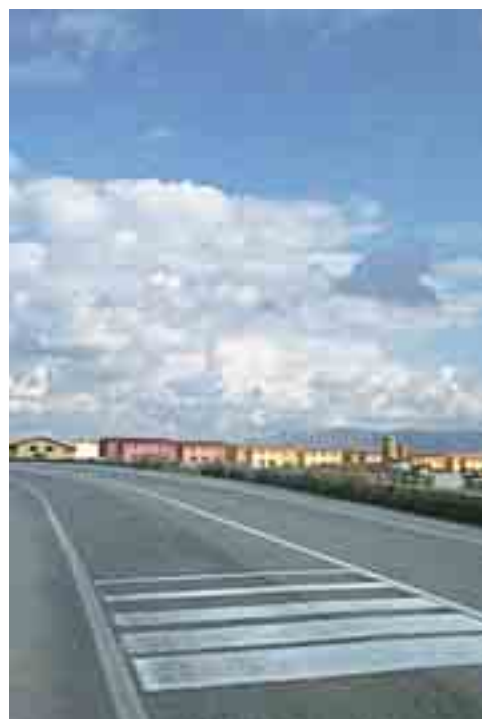
UN TRATTO DELLA CATANIA-GELA NEI PRESSI DI MINEO
